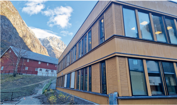
Fasaden mot vest og den rehabiliterte låven i bakgrunnen.
